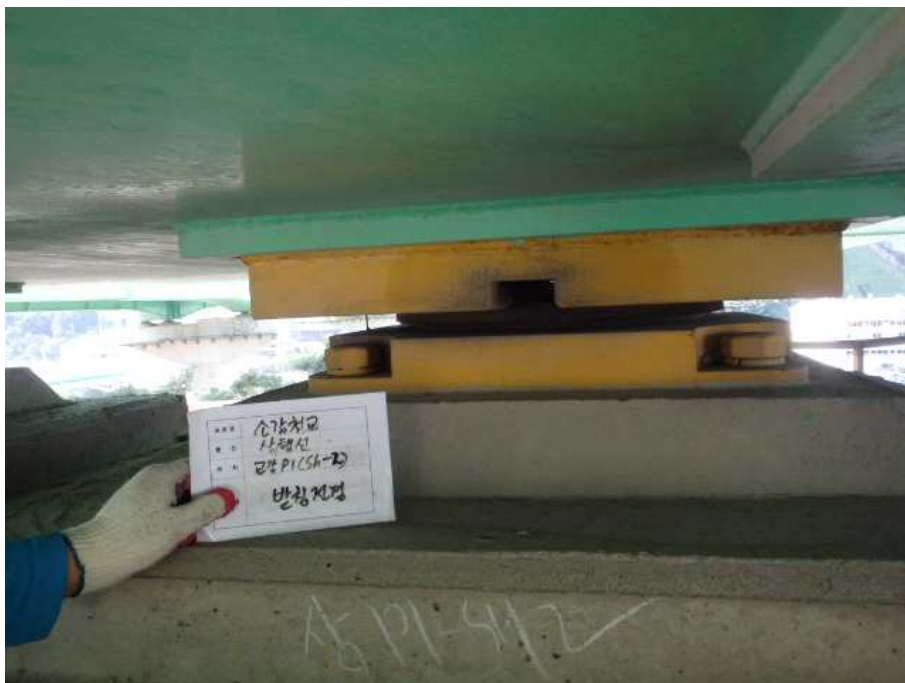
받침장치 전경 (가동단)
