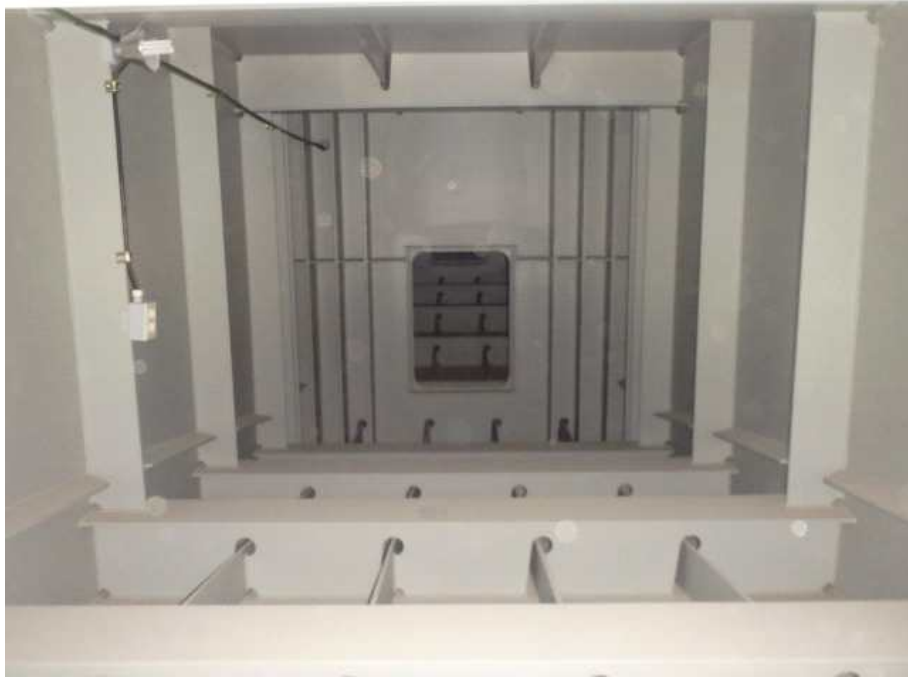
Steel Box Girder 내부 전경
